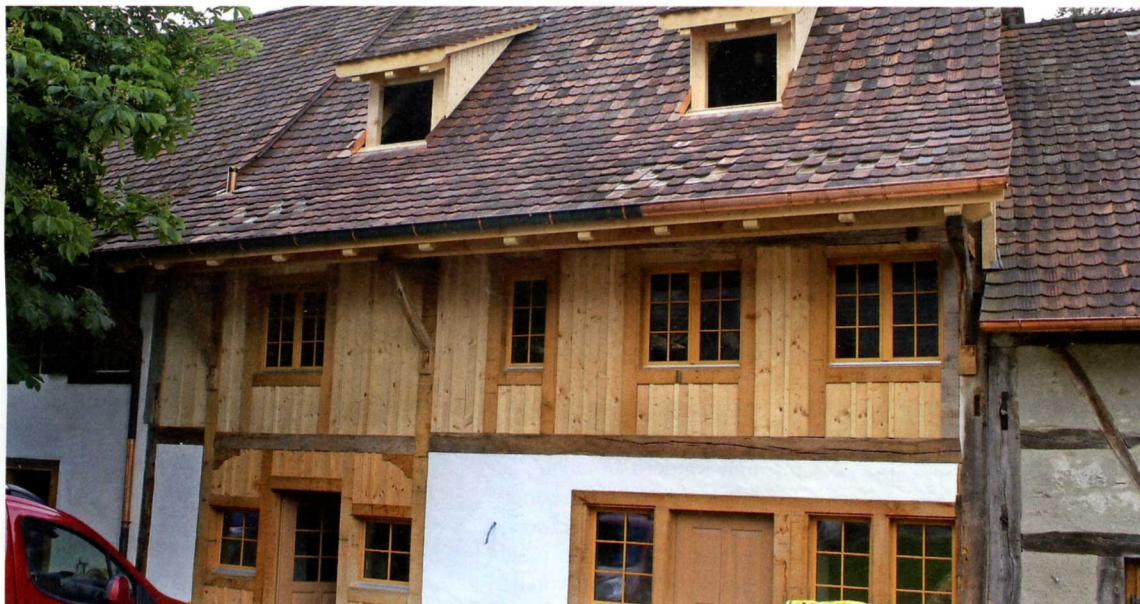
Einen grossen Schritt weiter ist man beim Umbau des denkmalgeschützten Hauses in Ramsen.
